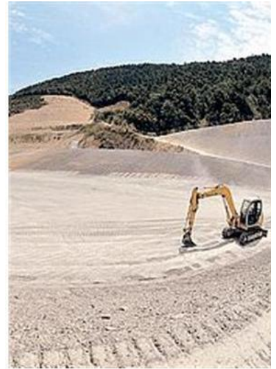
LA CAVA I lavori in corso a Monte La Poggia
